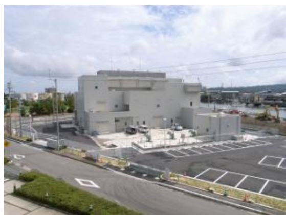
小松島雨水ポンプ場
