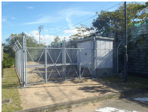
非常用耐震性貯水槽（和田島緑地）
