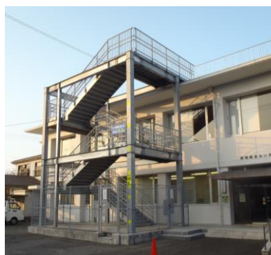
泰地総合センターに設置した津波避難用屋外階段
