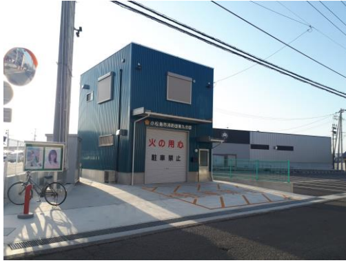
小松島市消防第9分団 詰め所の移転・新築
