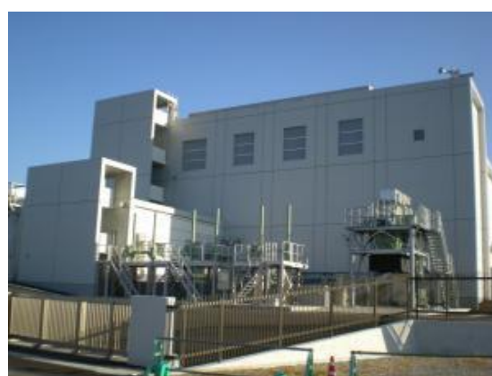
金磯南雨水ポンプ場
