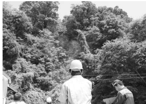
危険箇所の点検を行う関係機関の職員ら
