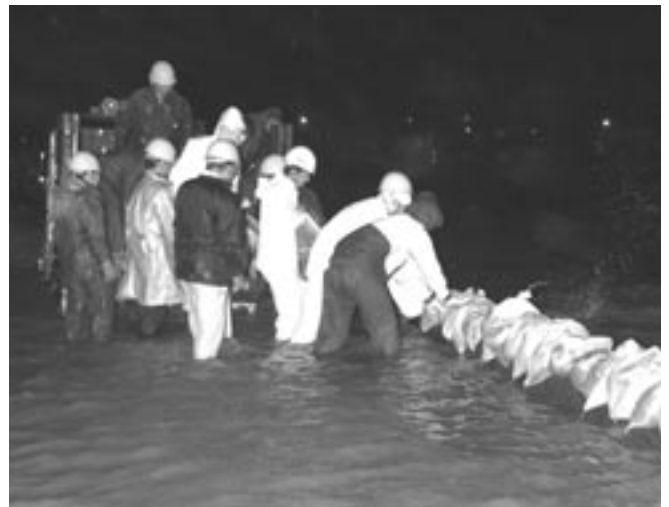
【写真上】平成16年10月の台風23号による水害で堤防に土のうを積み上げる市職員ら(赤石町の立江川堤防)
