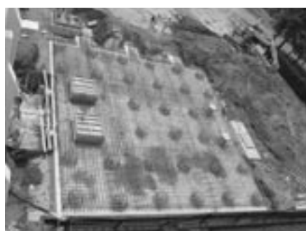
写真は、H20, 6, 16現在の基礎工事の全景です。
