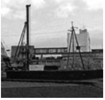
基礎杭打設状況 (4月8日撮影)
