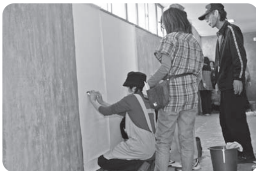
壁紙の張り替え作業をする受講生ら
