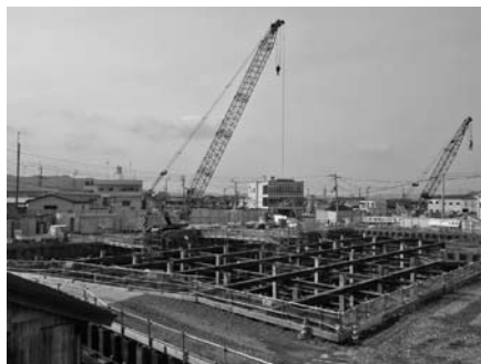
金磯南雨水ポンプ場建設工事の状況 （平成24年3月8日現在）
