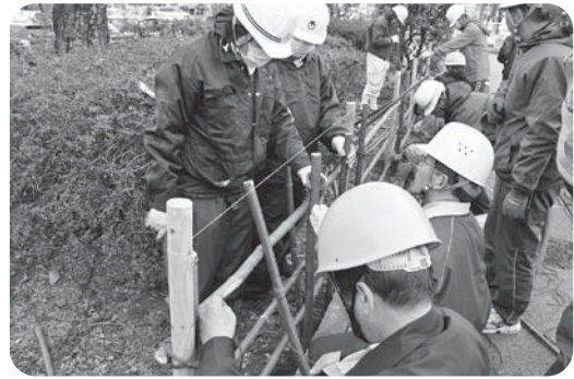
竹を組み合わせて四つ目垣を設置
