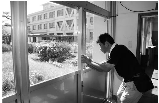
飛散防止フィルムを張り付ける様子
