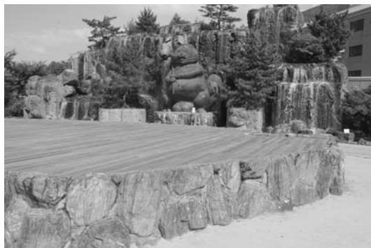
床材が張り替えられた野外ステージ
