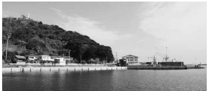
徳島小松島港元根井地区
